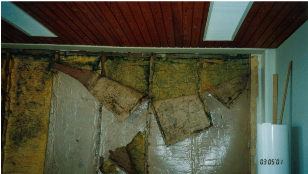
Kuva 3. Mikrobivaurio seinärakenteessa (10.)
