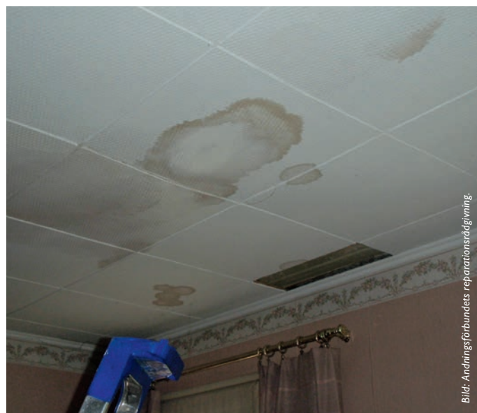
Spår av fukt i mellanbjälklaget förorsakade av takläckage.
