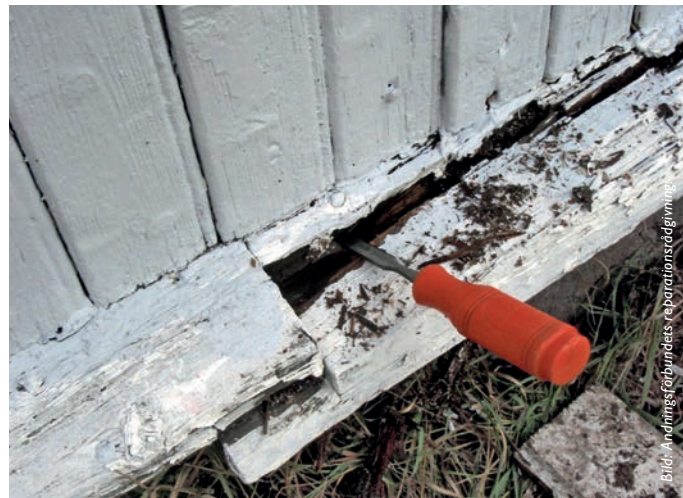
Brädfodringen och formlisten är murkna eftersom det inte finns någon luftspalt bakom brädfodringen.
