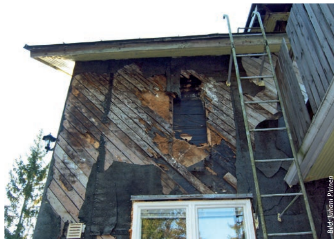
En tät filt på fel plats på konstruktionens utsida kan orsaka allvarliga skador.
