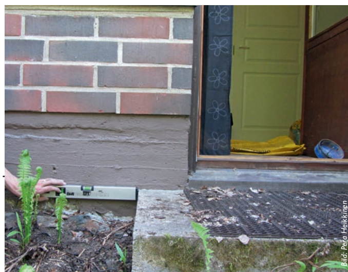
När ytterdörrens nedre kant är betydligt lägre än sockelns övre kant är det fråga om en blindsockel.
