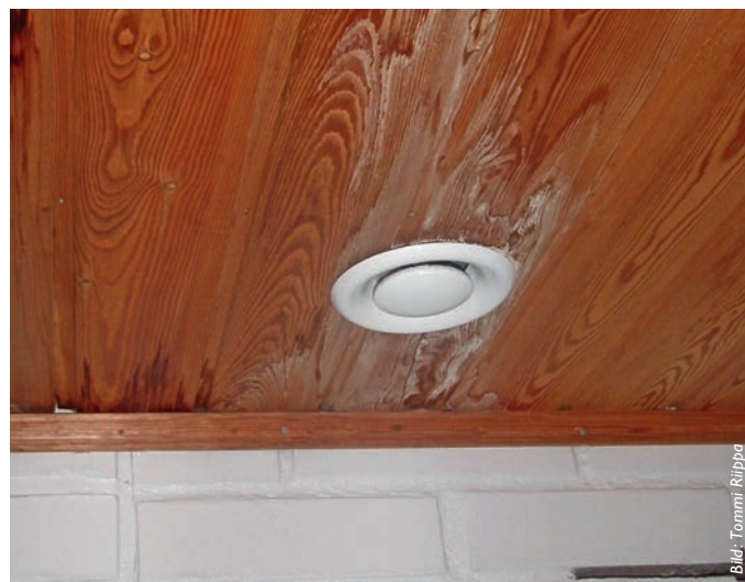
Ventilationens frånlufts rör har isolerats dåligt, varvid det har bildats kondens som har vätt ner konstruktionerna.
