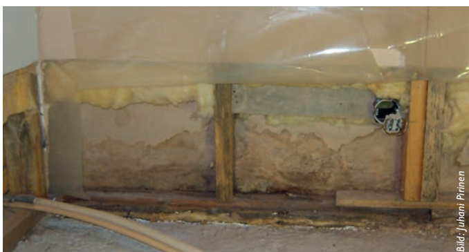
Skador på syllan upptäcks vanligen först när konstruktionerna öppnas.
