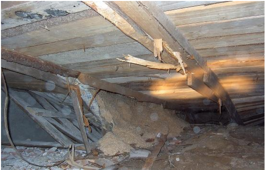
Kuva 7. Huonon tuuletuksen, tuulettutilassa olevien orgaanisten aineiden ja kosteuden yhteisvaikutus on johtanut alapohjan romahdukseen (Pirinen 2011)
