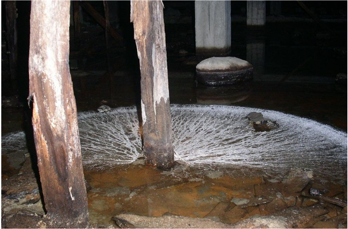
Kuva 6. Esimerkki kosteusvauriosta alapohjatilassa
