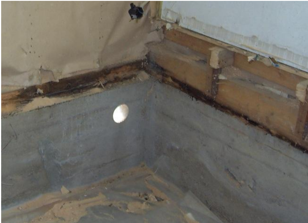
Kuva 17. Kapillaarikatkon puuttuminen betonin ja puun väliltä on johtanut puurakenteiden vaurioitumiseen (Pirinen 2011.)
