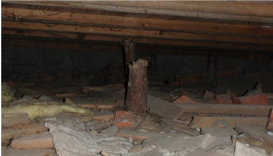
Kuva 25. Painunutta lattiaa on pyritty korjaamaan puutolpalla. Ryömintätalassa on myös sinne kuulumatonta rakennusjätettä. (Heli 2011)
