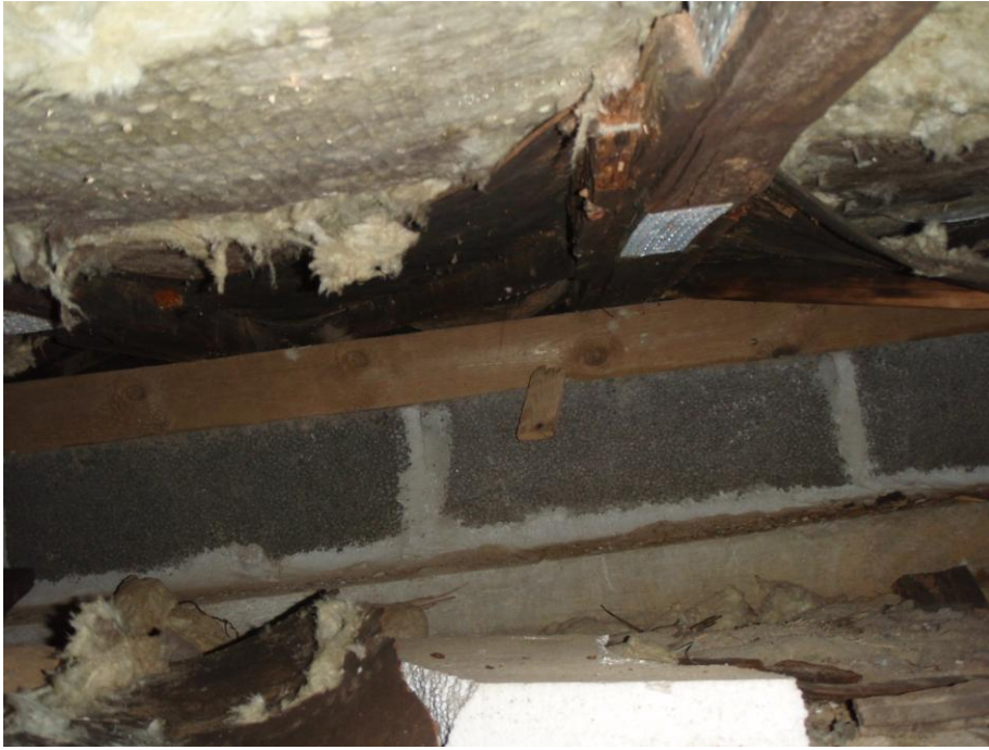
Kuva 10. Heikosta tuuletuksesta johtuvia vaurioita puualapohjassa (Heli 2011)
