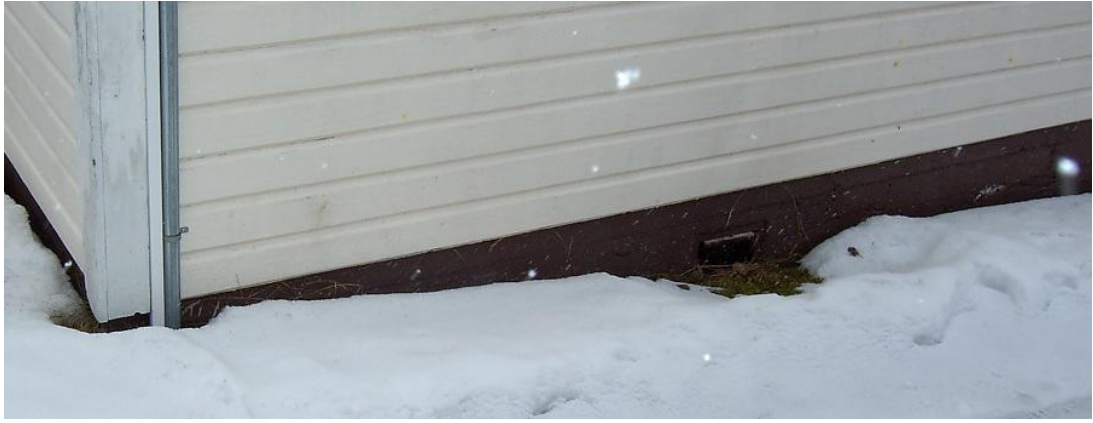
Kuva 11. Esimerkki tuuletusaukon riskialttiista sijainnista (Pirinen 2011)
