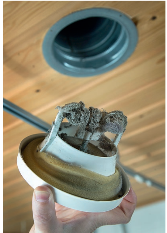
Pölyiset venttiilit heikentävät ilmanvaihtoa ja siksi niiden puhdistuksesta tulee huolehtia.
