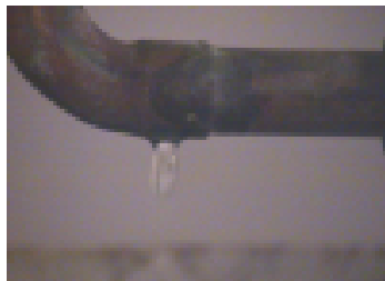
Vuoto käyttövesiputkessa.
