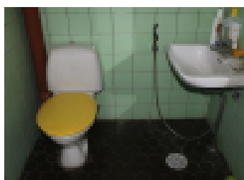
Vanhojen laatoitusten alla ei yleensä ole vedeneristeitä.
