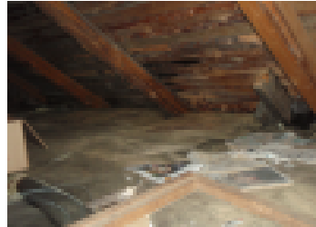
Eristeiden päälle levitetty bitumihuopa aiheuttaa kosteus- ja homevaurion.
