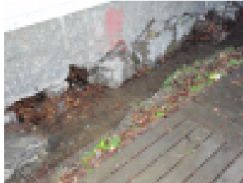
Vedet jäävät seisomaan talon vierustalle ja kastelevat perustuksia sekä alapohjaa.
