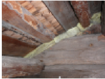
Yläpohjan tuuletusraot tukittu.
