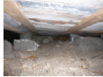
Rossipohja on matala ja tuuletusaukot puuttuvat. Rossipohja ei tuuletu.
