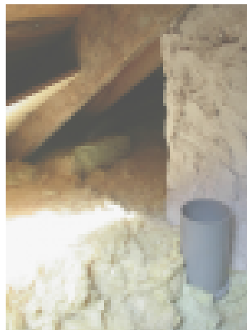
Yläpohjan tuuletustilaan loppuva viemärin tuuletusputki voi aiheuttaa kosteusvaurion.
