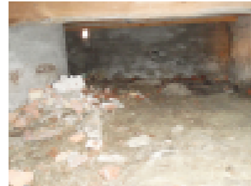
Rossipohjan betonipinnoissa on havittavissa kosteutta.
