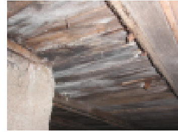
Alapohjan kunto pesuhuoneen kohdalta tutkittuna viittaa siihen, että vedeneristys ei ole toiminut.
