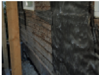
Hirsiseinän ulkopuolella ei saa olla vesihöyrytiivistä pintaa.
