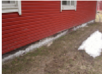
Salaojien puuttumisen aiheuttamia sokkelivaurioita.
