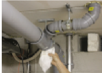
Tarkista viemäriputket säännöllisesti.
