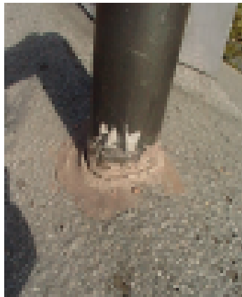
Viemärin tuuletusputken läpivienti ja huonokuntoinen huopakate.
