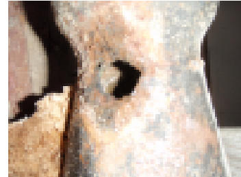
Keittiön viemärin salakavala vuoto purujen seassa.
