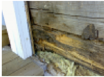
Hirsiseinän alimmissa hirsissä lahovaurio.
