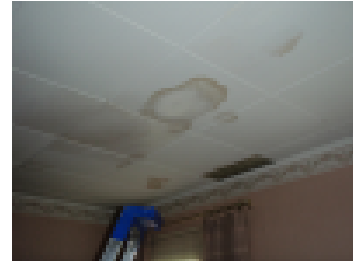
Kattovuodon aiheuttamia kosteusjälkiä välipohjassa.
