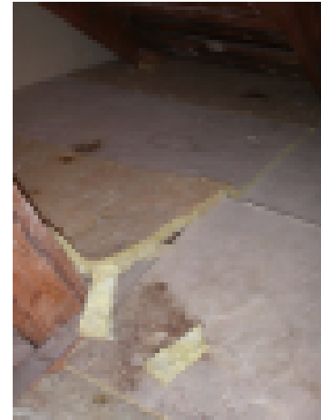
Lisälämmöneristyksellä on tukittu räystään tuuletusrako. Eristeen päällä myös vesijalkia.
