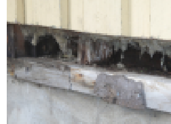
Pesuhuoneen puutteellinen vedeneristys tehnyt tuhoja.
