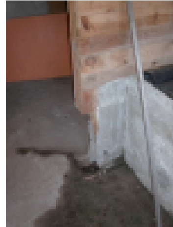
Märkää betonilattiaa kellarissa.
