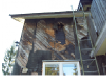
Tiivis huopa väärässä paikassa rakenteen ulkopinnalla.
