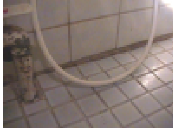
Laatoitettuja pesuhuoneen pintoja.
