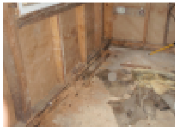
Ulkoseinän uloin paperipinta on kastunut. Syy voi olla sisäilman kosteus, joka tiiviytyy kylmän rakenteen pintaan.
