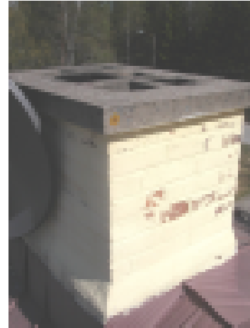
Savupiippu, josta puuttuu piipunhattu.
