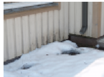
Sulava lumi kastelee seinärakennetta.
