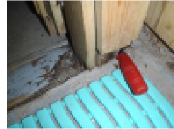
Betonia vasten ja betonin sisällä olevat puurakenteet lahovaurioituvat ennen pitkää.
