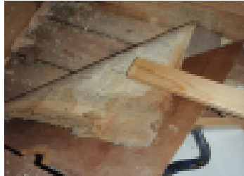
Alkuperäisten lattiarakenteiden ilmatiiviyydessä on parantamisen varaa.
