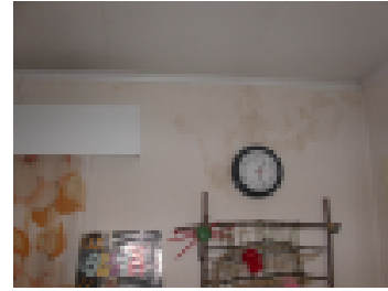
Kosteusjälkiä ulkoseinän sisäpinnalla.
