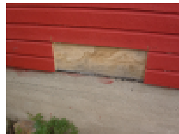
Julkisivulaudoituksen takana on kastunut pahvi, ei tuuletusrakoa.
