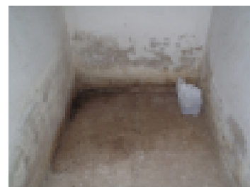
Märkiä kellarin rakenteita.
