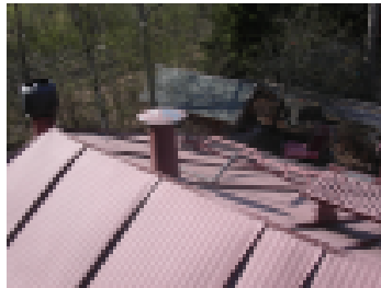
Vesikaton varusteita ja läpivientejä.
