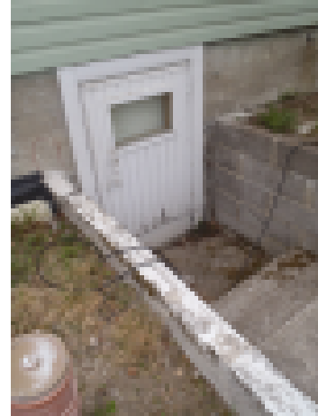
Kellariin johtavat porraskuilut ovat usein hankalia.
