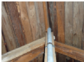
Antenniputken läpivienti vesikaton läpi on oltava tiivis.
