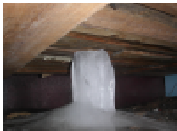
Lattiakaivon vuodon aiheuttama jäämökky rossipohjan tuuletustilassa.
