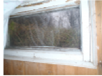
Kellarin ikkunaaan kohdistuu voimakas kosteusrasitus ulkoa.
