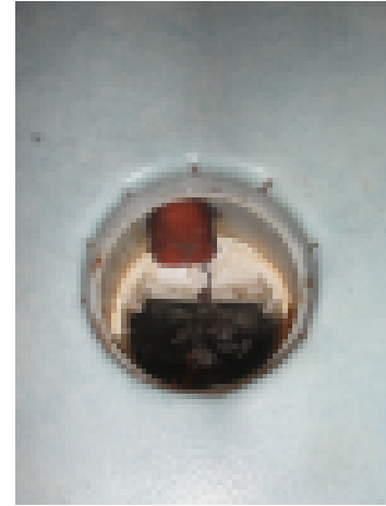
Lattiakaivon ja muovimaton epätiivis liittäjä.
