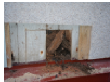
Vanha julkisivupinnoite on jätetty uudemman pinnoitteen taakse. Piiloon ovat jääneet myös seinärakenteen vauriot.
