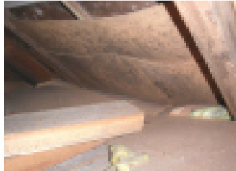
Ylimääräistä tavaraa eristeen päällä. Tiiviit pinnat eristeiden päältä on poistettava.
