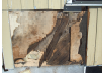
Huonosti asennetun ikkunapellin aiheuttama vaurio.
