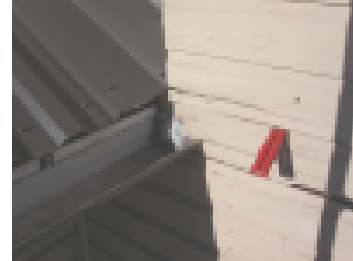
Räystäслиittymän aiheuttama julkisivuvaurio.
