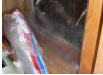
Kuuraa ja huurua sekä sisemmän että ulomman lasin sisäpinnoilla.
