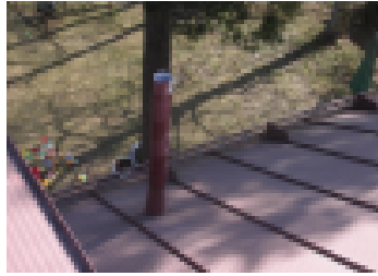
Eristämätön viemärin tuuletusputki.
