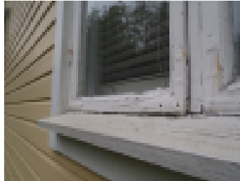
Puinen ikkunapelti on altis vaurioille.
