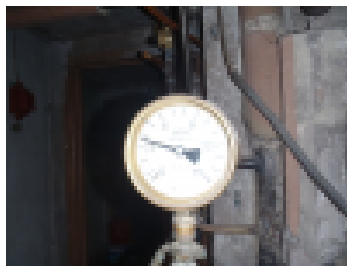
Mittarilukeman perusteella yläkerran pattereissa ei ole vettä.
