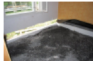
Vaurioituneen puukorokelattian tilalle tehdään uusi toimiva rakenne.
