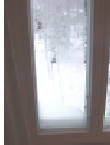
Ilmanvaihdon toimimattomuus näkyy huuruna ikkunassa.
