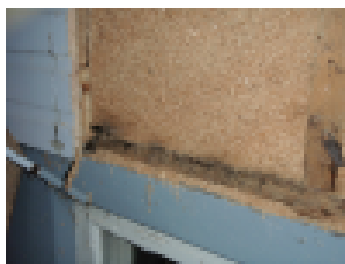
Pohjoispuolen ulkoseinä avattuna purut ja alajuoksu märkiä ja tummuneita.
