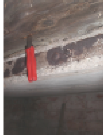
Kellarin betoniholvin päällä lahovaurioitunut lattiapalkki.
