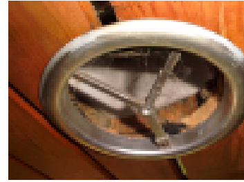
Poistoputki asbestia sisältävää Minerit-putkea.
