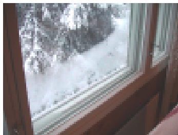
Kuuraa ulomman lasin sisäpinnalla.
