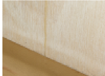
Hyväkuntoinen sauma muovitapetissa ja liitos muovimattoon.
