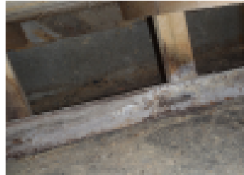
Vaurioitunutta puukorokelattian puurakenteita eristeiden poiston jälkeen.
