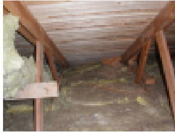
Räystään tuuletusrako on tukossa.
