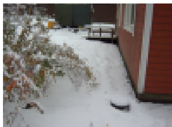
Maanpinta kallistuu taloon päin. Vedet ohjautuvat talon perustuksiin aiheuttaen kosteusongelmia.
