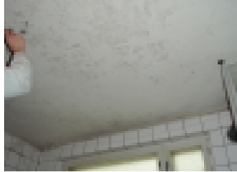
Huonon ilmanvaihdon takia kosteus tiivistyy pesuhuoneen kattoon ja mahdollistaa homekasvun.
