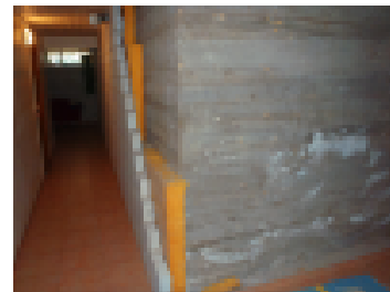
80-luvulla korjatun kellariseinän kosteusvaurio.
