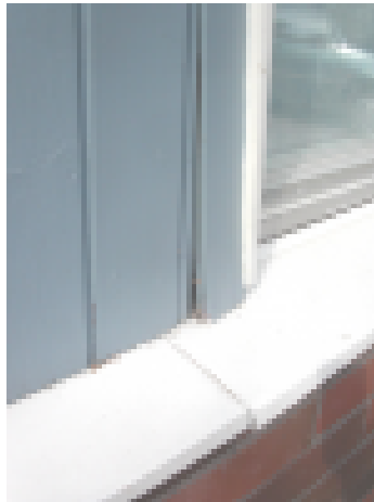
Viistosade pääsee laudoituksen rakosista sisään.
