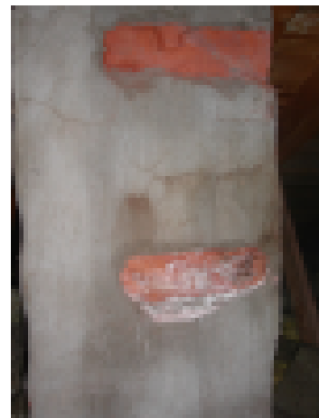
Savupiipulla ei ole hattua, ja hormoneihin pääsevä vesi rapauttaa savupiippua
