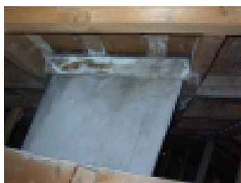
Vesijälkiä piipun juuressa.
