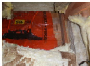
Mineraalivillapakkauksen suojamuovi ei täytä höyrnsulun vaatimuksia.
