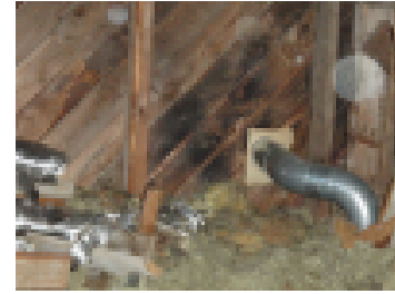
Liesituulettimen putki tukee eristää tuuletustilassa.
