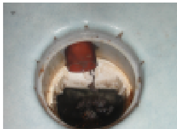
Vanhat pesukoneiden poistoputkien ym. liittymät lattiakaivoihin ovat usein epätiivitä.
