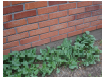
Tiiliseinän alaosassa ei ole tuuletusaukkoja.
