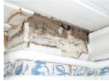
Piipun kattoläpivienti vuotaa ja aiheuttaa kosteusvaurion sisätiloihin.
