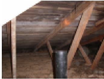
Viemärin tuuletusputki tulee viedä katteen yläpuolelle ja eristää.
