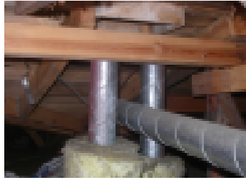
Osaksi eristämättömät ilmanvaihtoputket, jotka loppuvat myös kesken.
