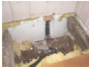
Jo kerran tehty korjaus ei ole onnistunut, koska maaperän kosteuslähteitä ei ole poistettu.
