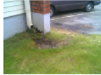
Syöksytorvi kastelee perustukset.
