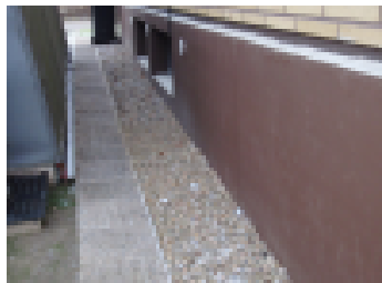
Ulkopuolelle tehty kattovesien ja pintavesien poisohjaus, salaojat sekä vesi- ja lämmöneristys.
