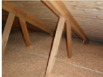
Sivuräystään tuuletusraot ovat tukossa, mutta rakenteet ovat visuaalisesti arvioiden vielä kunnossa.
