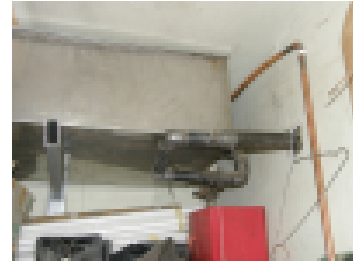
Vasta uusittu avonainen paisunta-astia.
