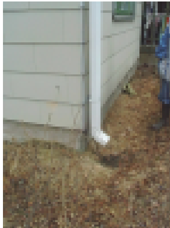
Vesi lammikoituu syöksytorven alle.
