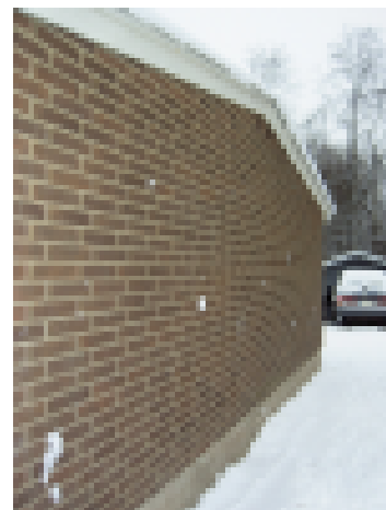
Räystäään kapeuden vuoksi viistosateelle altis seinä.
