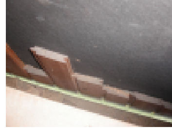
Julkisivulaudoituksen alla ei ole tuuletusrakoa.
