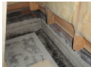
Valesokkelin korjaus. Rakenteet purettu.
