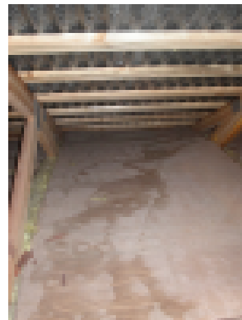
Kosteusjälkiä yläpohjassa. Aluskate puuttuu.
