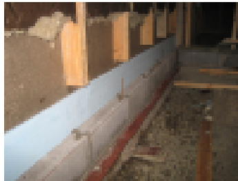
Vaurioituneen lattian ja valesokkelirakenteisen ulkoseinän alaosan korjaus meneillään.
