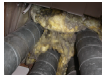
Höyrnsuluton ilmanvaihtoputkien läpivienti yläpohjaan.
