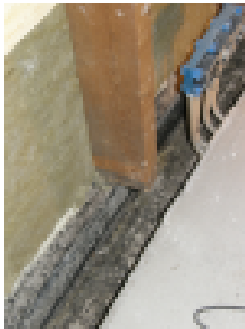
Valesokkelin takaiset vaurioituneet puurakenteet on purettu pois.
