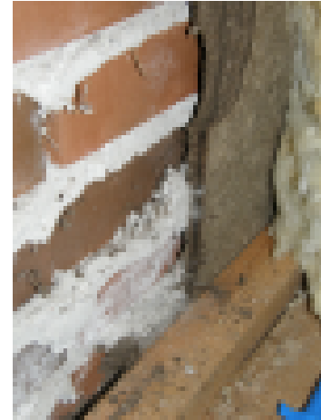
Sisäpuolelta avattu rakenne paljastaa, että tuulensuojalevy asennettu suoraan tiiliverhousta vasten, ja tuuletusrakoa ei ole.
