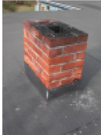
Piipusta puuttuu valukansi ja sadehattu.
