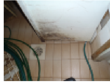
Kalustemateriaali ei ole tarkoitettu märkätilojen seinämateriaaliksi.
