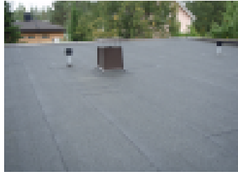
Esimerkillisesti hoidettu tasakatto.
