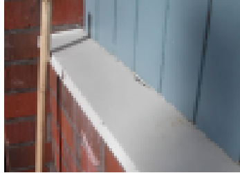
Laudat ovat pellityksessä kiinni, ja tuuletus estyy samalla.
