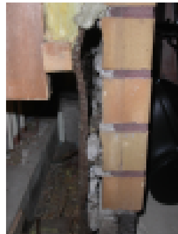
Laastilla tukkeutunut tuuletusrako tiiliverhoilun takana.
