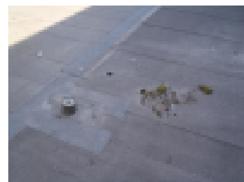
Kattokaivo on kyllä puhdistettu, mutta roskat on jätetty kaivon viereen.
