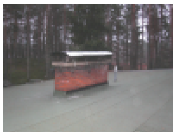
Savupiippu ja viemärin tuuletusputki.
