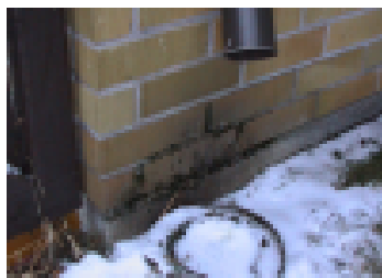
Turhan lyhyen syöksytorven alla tiiliverhoilu ulkoseinä on kastunut.
