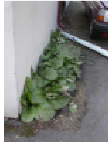
Kukkapenkki terassin vierellä. Talon perustukset eivät pääse kuivumaan.
