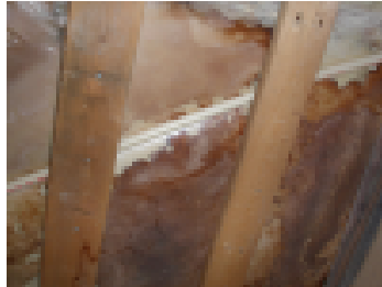
Kylmiön kohdalla yläpohjassa vaurioita.
