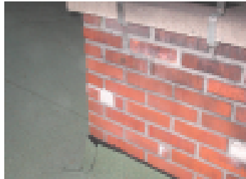
Tiilipiippu on jo hieman vaurioitunut piipunhatusta huolimatta.
