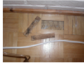
Liian kosteasta betonilattiasta irronneita parkettisauvoja.
