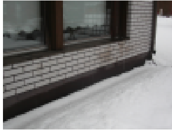
Märkä tiiliverhous ja valesokkeli.
