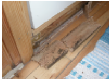
Kylpyhuoneen kynnyks on ollut liian matala, ja rakenteen sisään on päässyt vettä.
