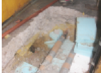
Mineraalivillalla alapuolelta eristetystä lattiasta löytyi kosteusvaurio.
