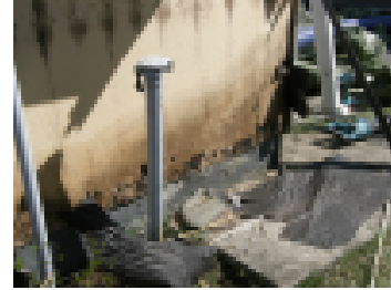
Tuulettumattoman julkisivulaudoituksen tausta.
