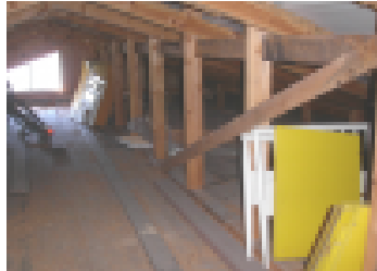
Kun tasakaton päälle tehdään harjakatto, tulee myös vanhan kattorakenteen tuulettumista parantaa.
