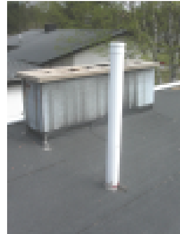
Eristämätön viemärin tuuletusputki voi jäättyä katolla ja aiheuttaa sisälle hajuhaittoja.
