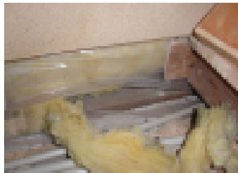
Ulkoseinän ja piilobetonilattian liittymä, josta pääsee ilmavirtoja aina sisätilaan saakka.
