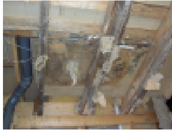
Vessan muovimatto on vuotanut. Näkymää lattian alapuolelta.
