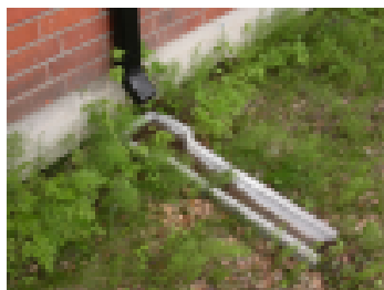
Lyhyt ja väärään suuntaan kallistettu loiskekouru.
