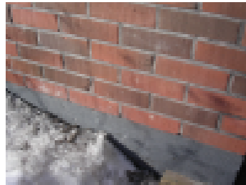
Tiiliverhouksen alaosassa ei ole ollenkaan tuuletusrakoa.
