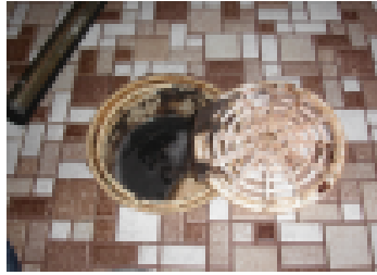
Puhdista lattiakaivot säännöllisesti.
