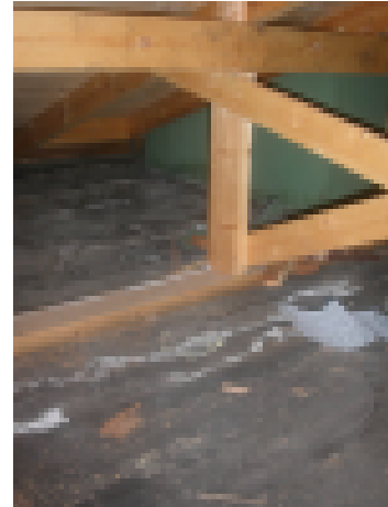
Vanha tasakatto on jätetty huopineen paikalleen, ja uusi kattokin on jo vuotanut.
