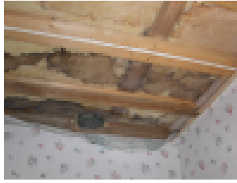
Vuotava vesikaton aiheuttamia vaurioita.
