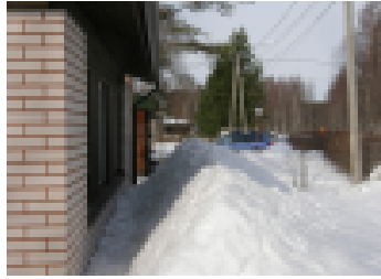
Seinän viereen kasautunut lumi kastelee rakenteita.
