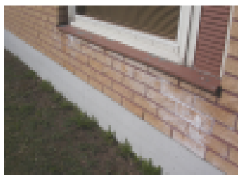
Kostunut tiiliseinä.
