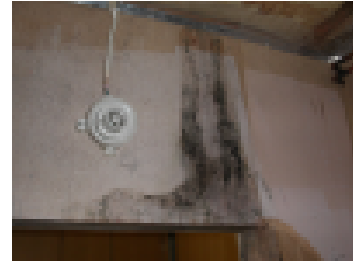
Entisen kylmiön kohdalta paljastuneita vaurioita.
