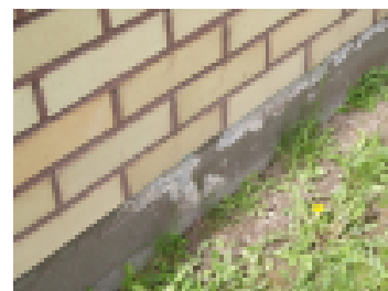
Kosteusjälkiä valesokkelin ulkopinnalla.
