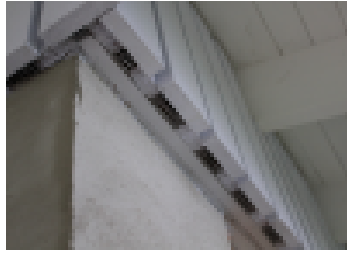
Julkisivulaudoitus tuulettuu, ja tuuletusraot on suojattu jyr sijäverkolla.
