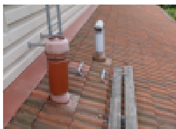
Tarkista, että kattovarusteiden kiinnityskohdat ovat ehjiä.
