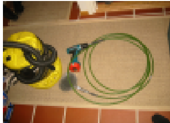
Ilmanvaihtokanaviston puhdistuksessa tarvittavaa välineistöä.
