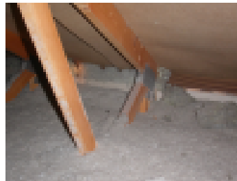
Puhalluseristeellä osin tukittuja tuuletusaukkoja.
