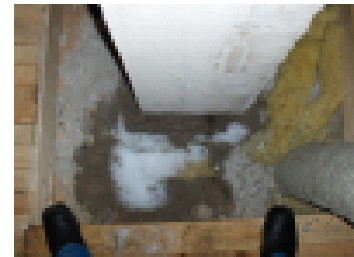
Pyrylunta yläpohjan päällä hormin vieressä.
