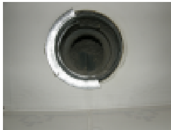
Puhdistusta kaipaava ilmanvaihtokanava.
