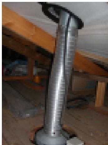
Ilmanvaihdon poistoputki yläpohjassa täytyy eristää.
