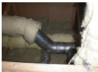
Ilmanvaihtokanavien eristäminen on jäänyt kesken.
