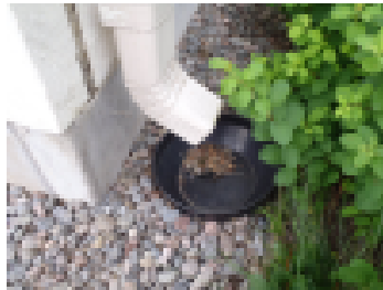
Vesi ohjautuu syöksytorvesta sadevesikaivoon ja edelleen sadevesiputkistoon.
