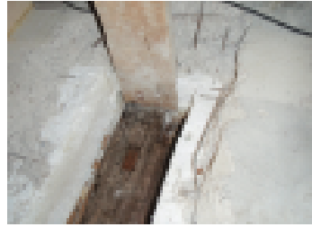
Seinän alaohjauspuu on kastunut.
