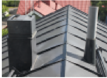
Vesikaton läpivientien tulee olla vesitiiviit.
