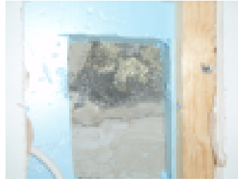
Kellarin seinän sisäpuolisen eristyksen takaa löytyi kosteusvaurio.
