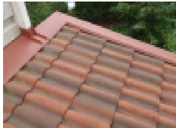
Kattomateriaalin ja räystäspelttien tulee olla ehjiä.
