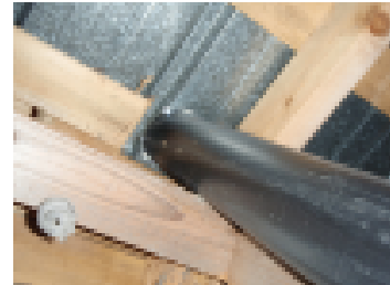
Sadevedet pääsevät kattorakenteisiin epätiiviestä läpiviennistä.
