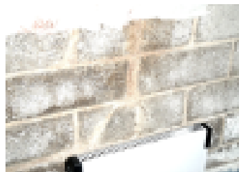
Kellarin harkkoseinä on märkä.
