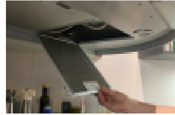
Liesituulettimen suodattimen irrottaminen ja puhdistus.
