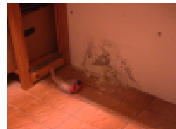
Kellarin seinään nousee kosteutta.
