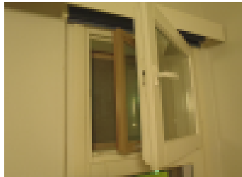
Tuuleta tarvittaessa ristituuletuksella. Jatkuva tuuletustarve kertoo riittämättömästä ilmanvaihdosta.
