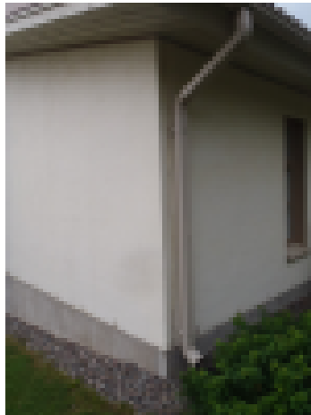
Myös syöksytorvien tulee olla ehjiä, ettei vesi roisku seinäpinnoille.
