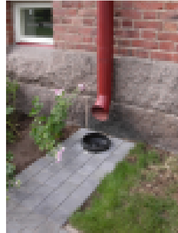
Kiveys rännikaivon ympärillä ohjaa ylitulvivan veden pois rakennuksen vieriltä.
